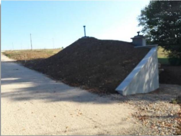
Réfection complète de la chambre réserve d'eau, du local des pompes, de toute la machinerie, ouverture d'une porte, étanchéité extérieure du bâtiment.
