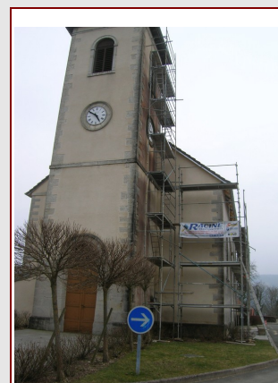
Nettoyage des façades et mise en peinture
